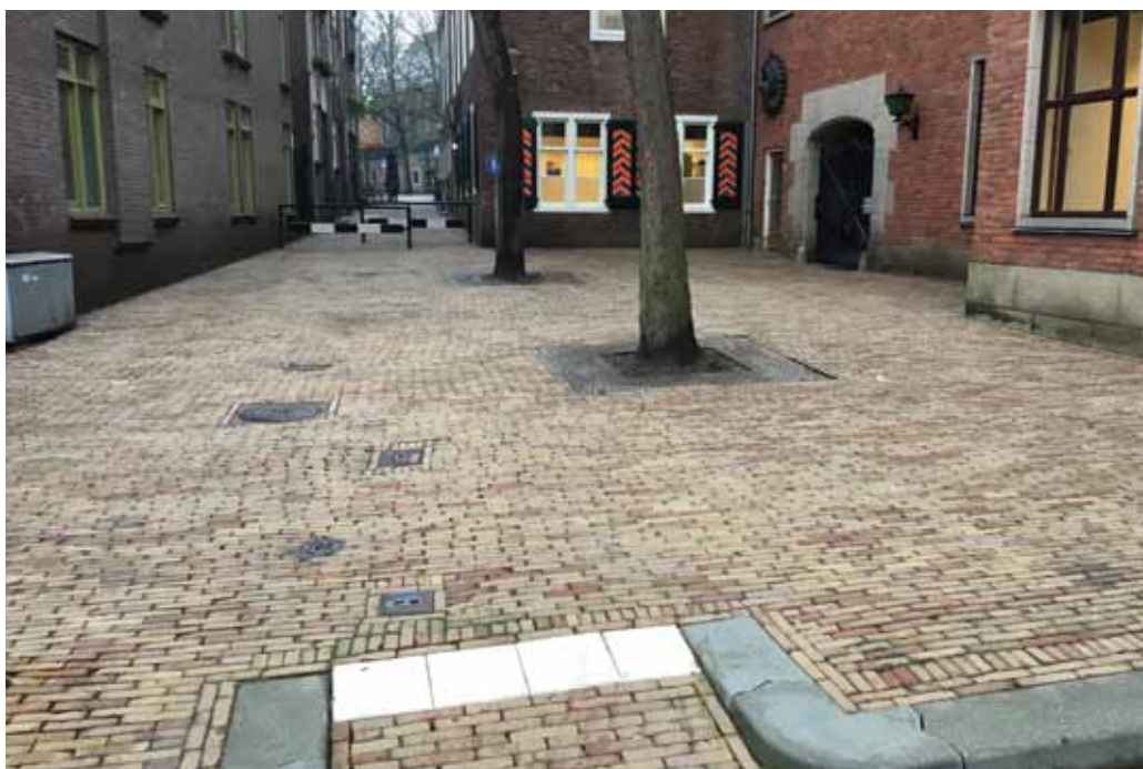
Straatbeeld in Vlaardingen na de werkzaamheden.
