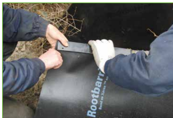
Het installeren van de Click bij een project in Rotterdam.
