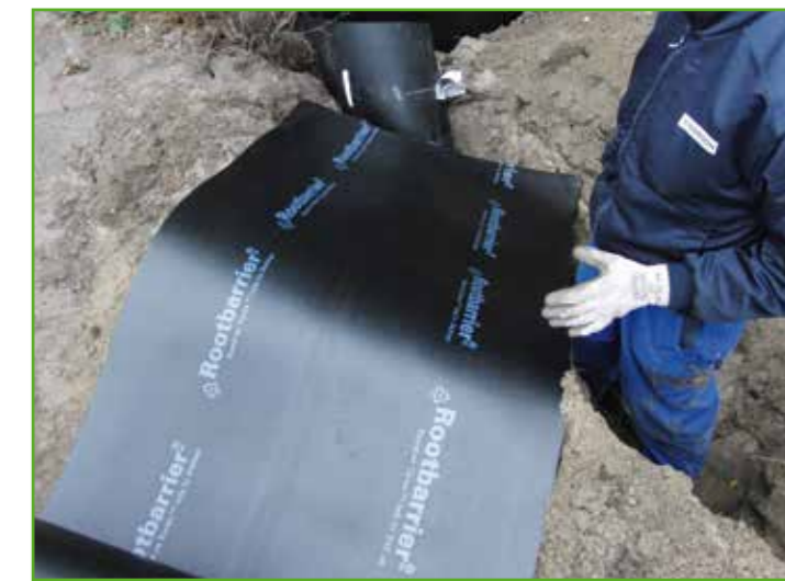
Het installeren van RootBarrier® 420 bij een tuin in Rotterdam.
