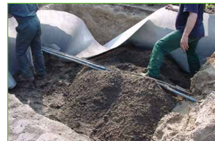
Ook rond kabels is RootBarrier® bij uitstek te gebruiken.
