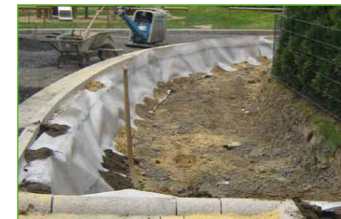
RootBarrier® 325 wordt geïnstalleerd bij een straatrenovatieproject in Gescher.
