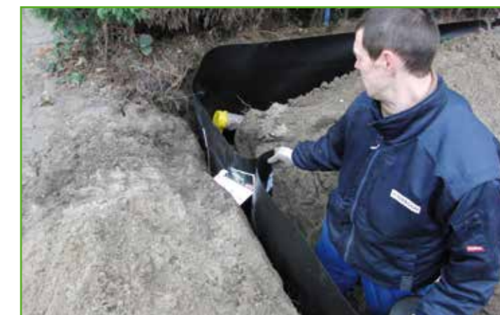
Om de uiteinden van de RootBarrier® 420 plaatsen we de ClickConnection.
