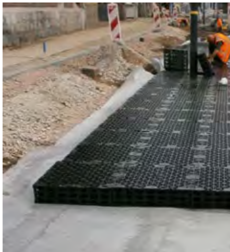
Aanbrengen sandwichconstructie in Roermond
