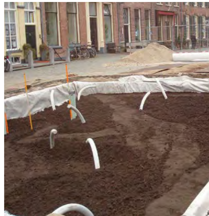
Opvullen van een groeiplaats met Bomengranulaat Lava
