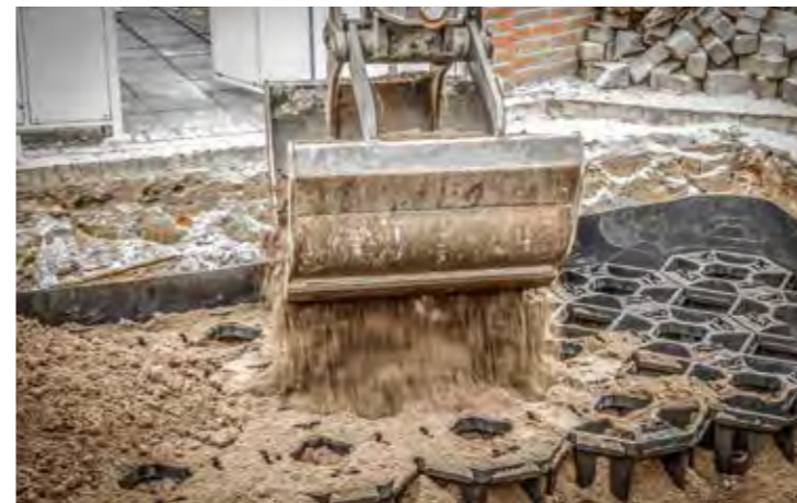
Aanbrengen Sandwichsubstraat
