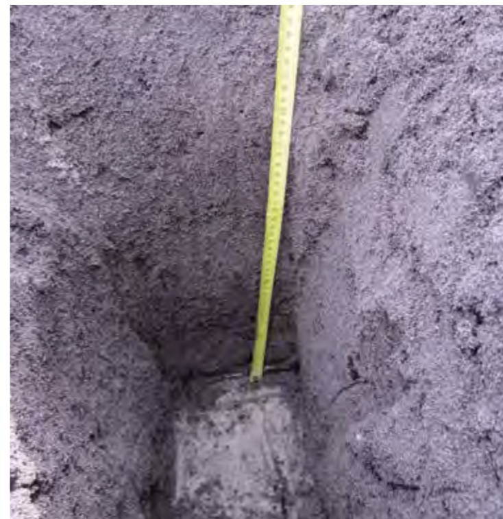
Proefkuil in recent aangebracht bomenzand
