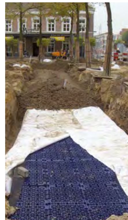
Aanbrengen EPDM-folie, vilten doek en kunststof kratten
