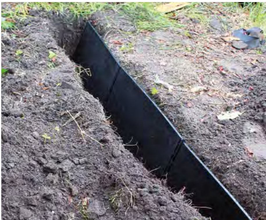
Verticale barrière middels kunststofplaten
