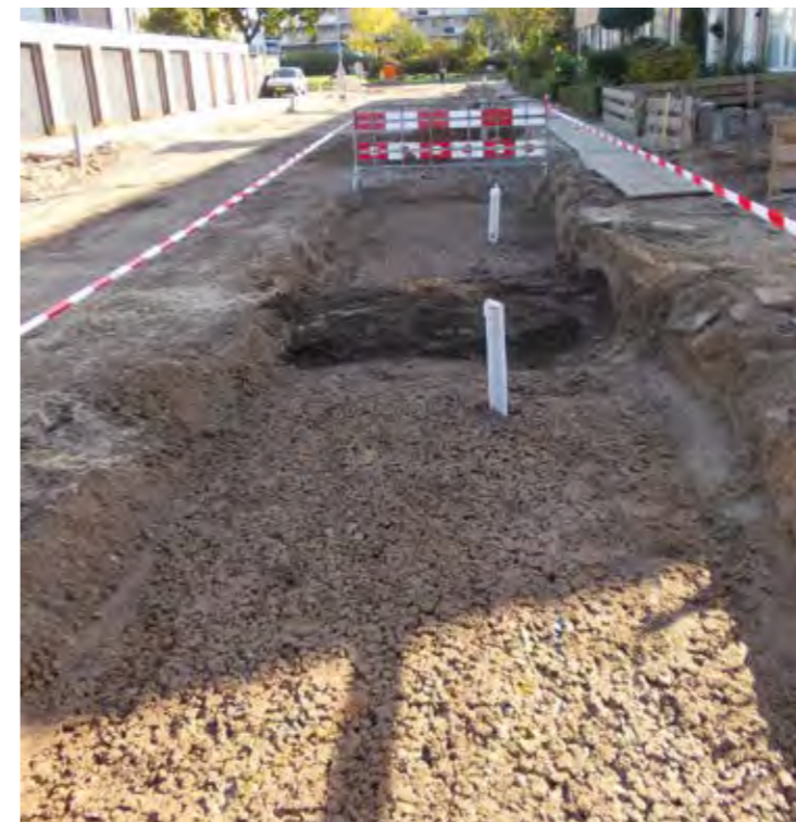
Aangebracht Bomengranulaat Grauwacke
