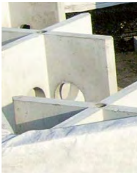
Frame van prefab betonelementen
